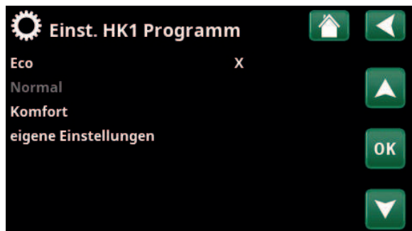
Menü „Fachmann/Einstellungen/Heizkreis/Heizkreis 1/Programm“.
