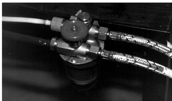
In tale caso la pompa viene lasciata nell'esercizio a doppio circuito. Montare sul filtro i tubi flessibili di mandata e di ritorno del bruciatore. Aprire il rubinetto dell'olio sul filtro. Mettere in funzione l'impianto.
