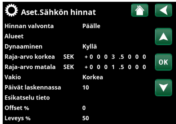
Valikko "Edistyneempi/Asetukset/Kommunikaatio/Sähkön hinnat", valittuna "Edistyneempi/Asetukset/Kommunikaatio/myUplink:Kyllä".
