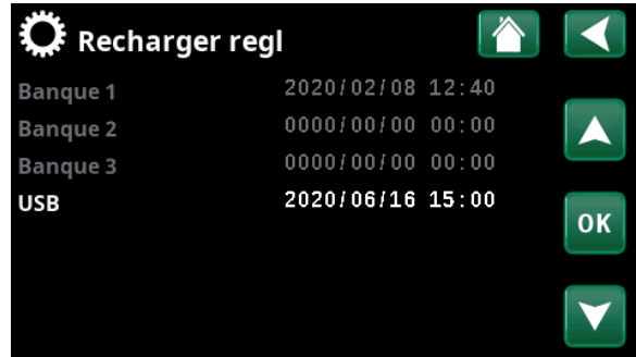
Menu : «Installateur/Réglages/Recharger regl».
