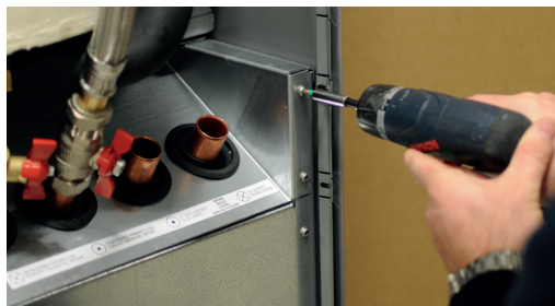
3. Skru kølemodulets skruer af.
