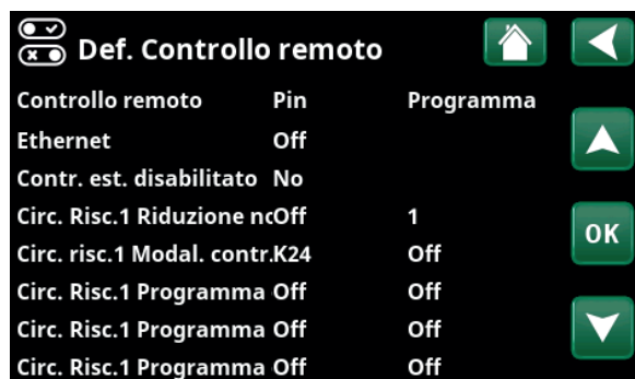
Parte del menù "Installatore/Definire/Controllo remoto". Qui vengono definiti "Input" e "Programma settimanale".
