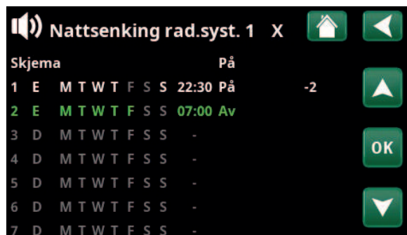
I skjemat er det stilt inn at «Nattsenking» skal være aktiv ukedager mellom 22.30 og 07.00, bortsett fra natten mellom fredag og lørdag samt natten mellom lørdag og søndag (da det ikke er nattsenking).
