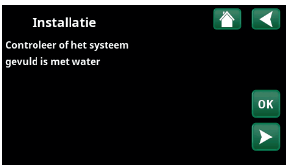
3. Controleer of het systeem gevuld is met water. Bevestig met "OK" en de "pijl naar rechts".
