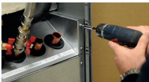
3. Retirez les vis de fixation du module de refroidissement.
