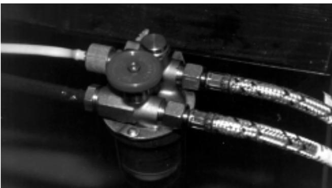
Für die Umstellung auf Einstrangsystem empfehlen wir den Einsatz eines Heizölfilters mit Rücklaufzuführung. Dabei wird die Pumpe im Zweistrangbetrieb belassen. Vor- und Rücklauf-Brennerschläuche am Filter montieren. Ölhahn am Filter öffnen. Anlage in Betrieb nehmen.
